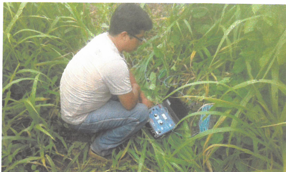
VISTA DE MEDICION DE PUESTA A TIERRA
