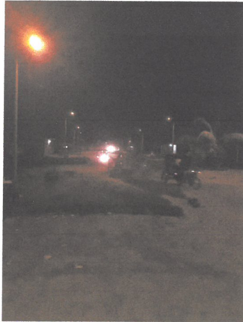
VISTA DE PRUEBA EN CALIENTE DE LUMINARIAS
