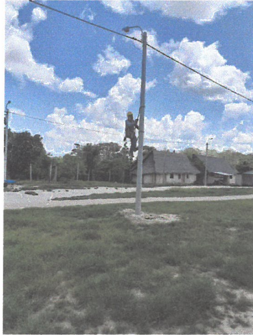
VISTA DE TECNICO A REALIZAR TRABAJAOS EN ALTURA
