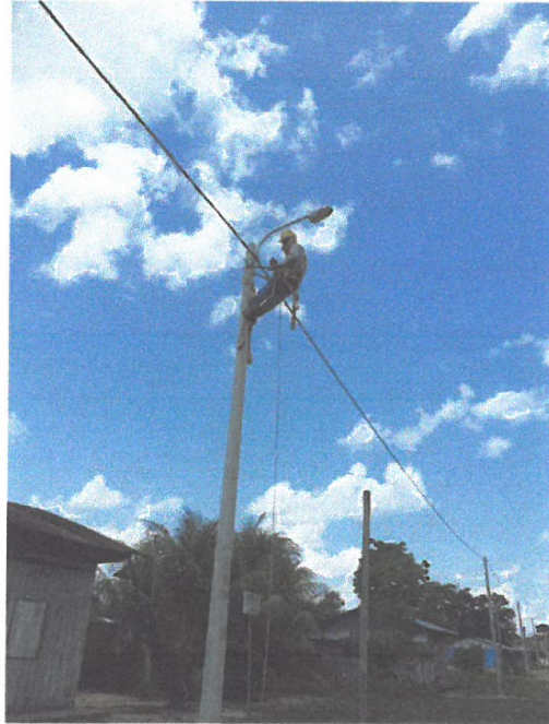
VISTA DE INSTALACION DE ACOMETIDAS
